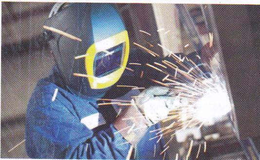
ในการเชื่อมเหล็ก ผู้ปฏิบัติงานจะต้องแต่งกายอย่างมิดชิดด้วยเสื้อผ้าที่หนา ใส่ถุงมือ และหน้ากากป้องกันแสงที่เกิดจากการเชื่อมเหล็ก
